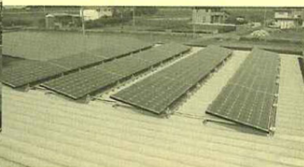
↓ 倉庫の屋根、設置例
